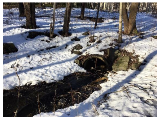
Figur 26. Dikets övergång till kulvert. Foto: Petter Söderberg/Nacka kommun.
